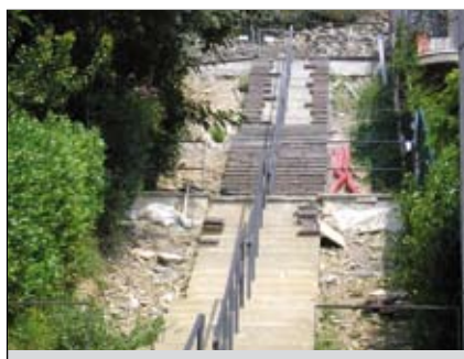
Realizzazione di un sentiero in via Monte Bastia. Costo: 59.000 euro
