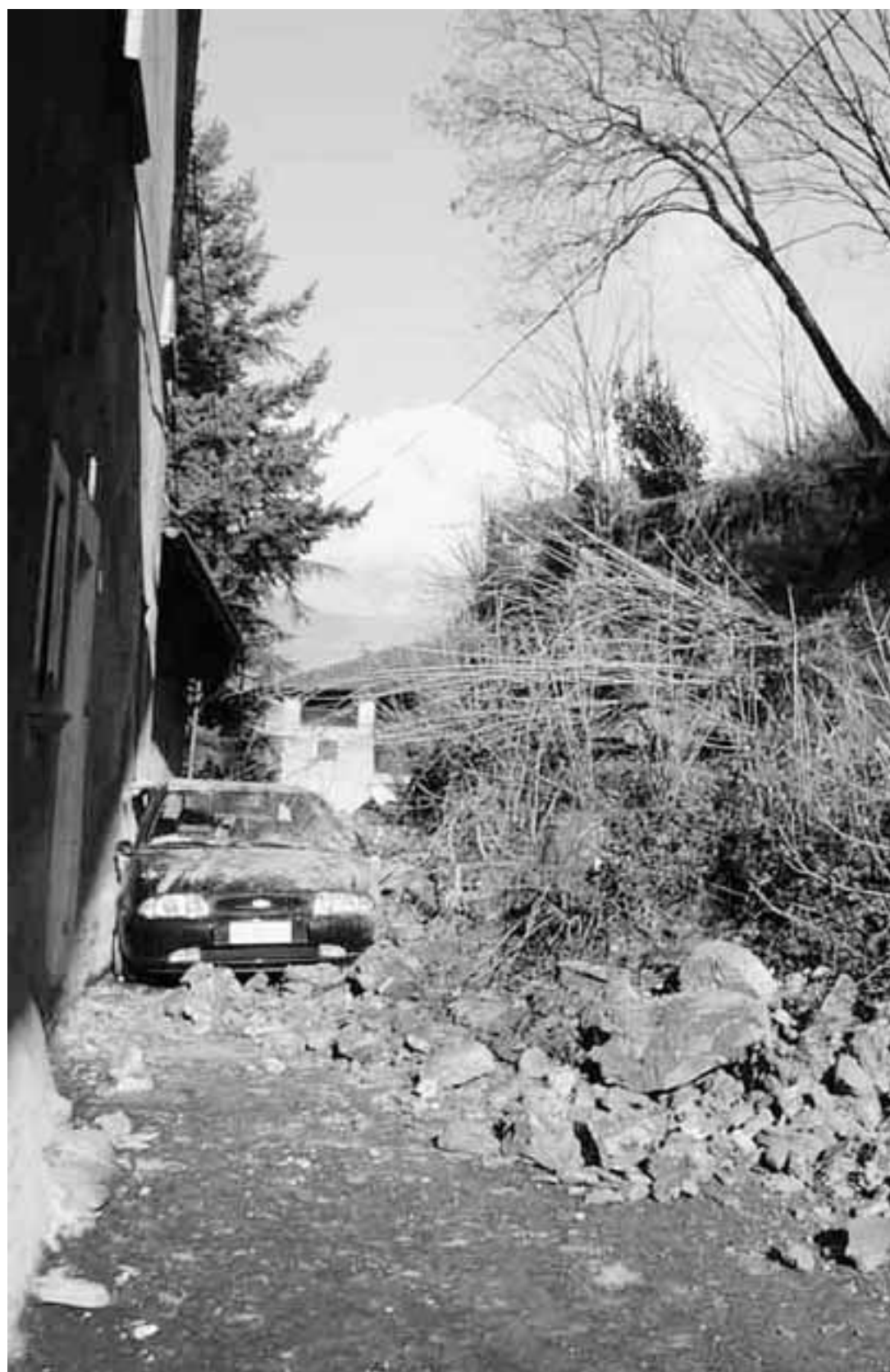
Via Forni a Scanzo: sopra, le prime fasi dei soccorsi dopo il crollo del muro di contenimento. Il terreno appesantito dall'acqua piovana è piombato sulla strada. A destra, una delle due auto sepolte; a fianco, le ricerche con i cani (foto Colleoni)
