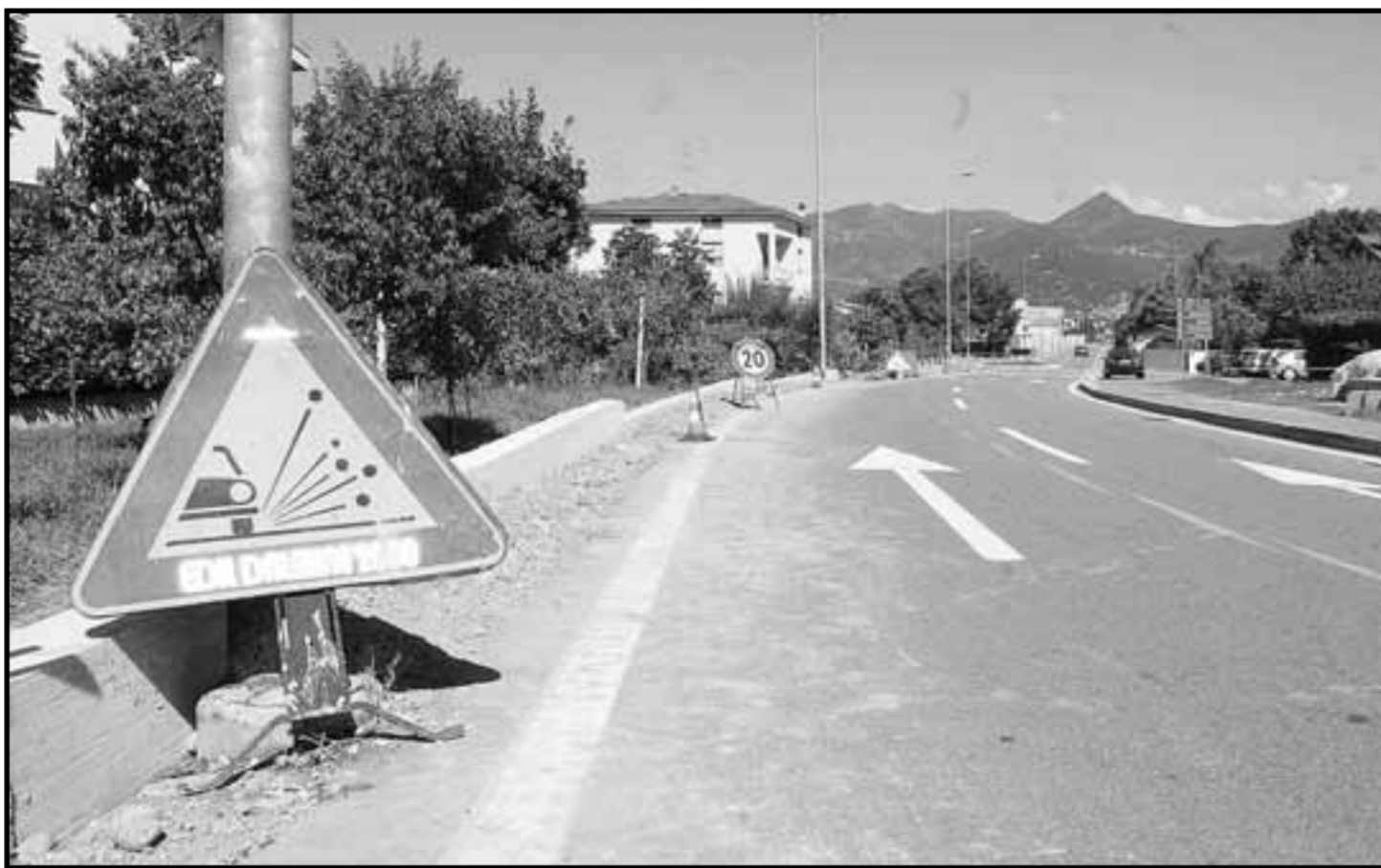
Lavori in corso in via Manzoni, a Scanzorosciate (foto Thomas Magni)
