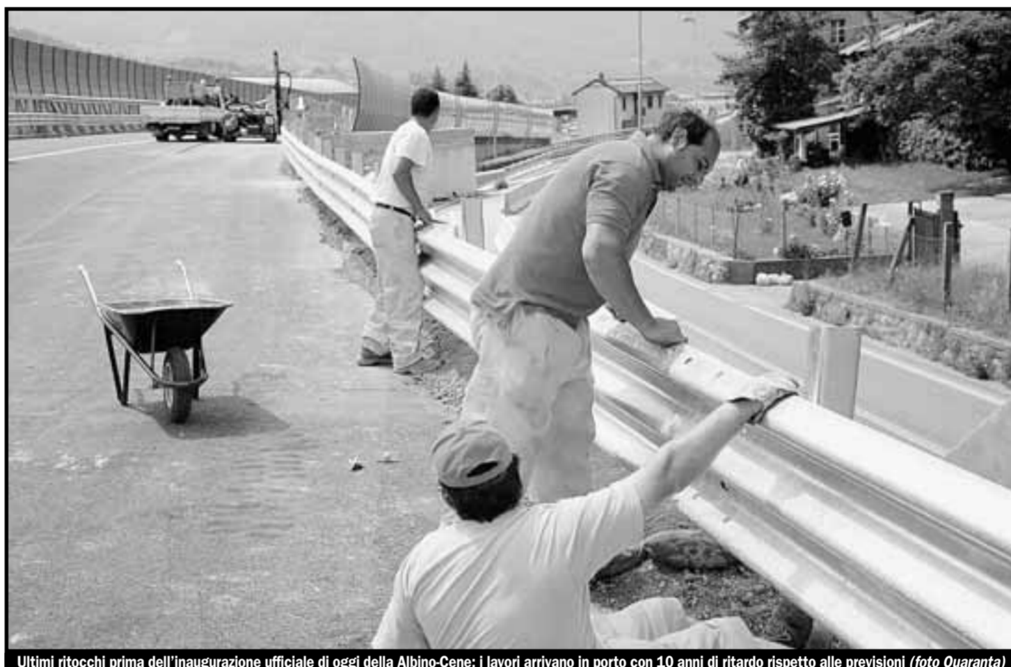
Ultimi ritocchi prima dell'inaugurazione ufficiale di oggi della Albino-Cene: i lavori arrivano in porto con 10 anni di ritardo rispetto alle previsioni (foto Quaranta)
