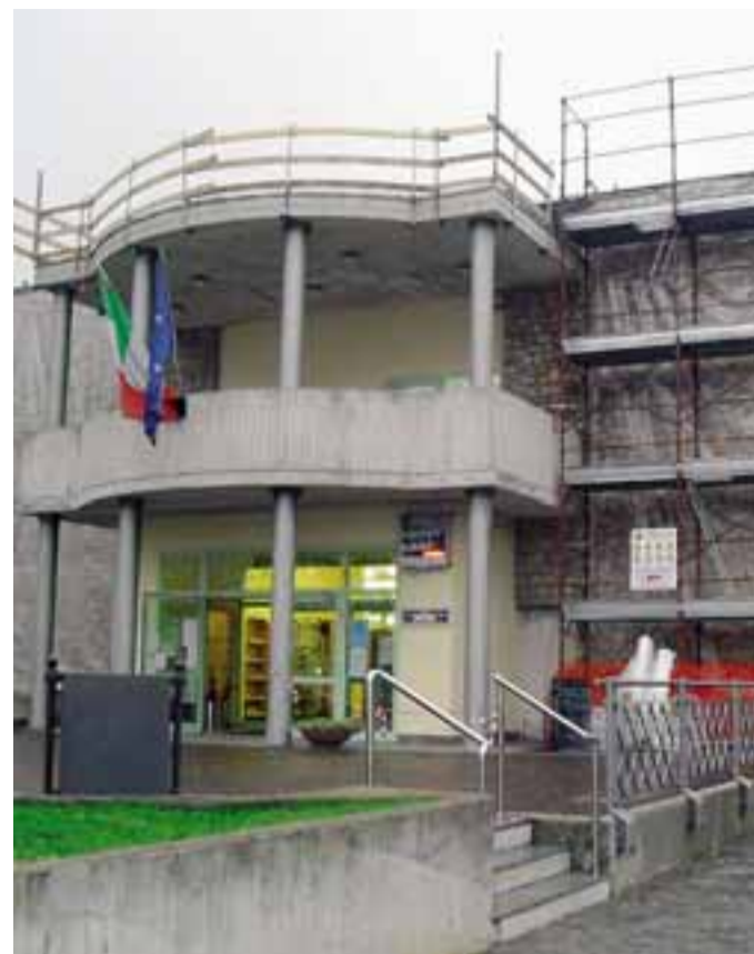
I lavori di ristrutturazione nella biblioteca di Scanzorosciate
