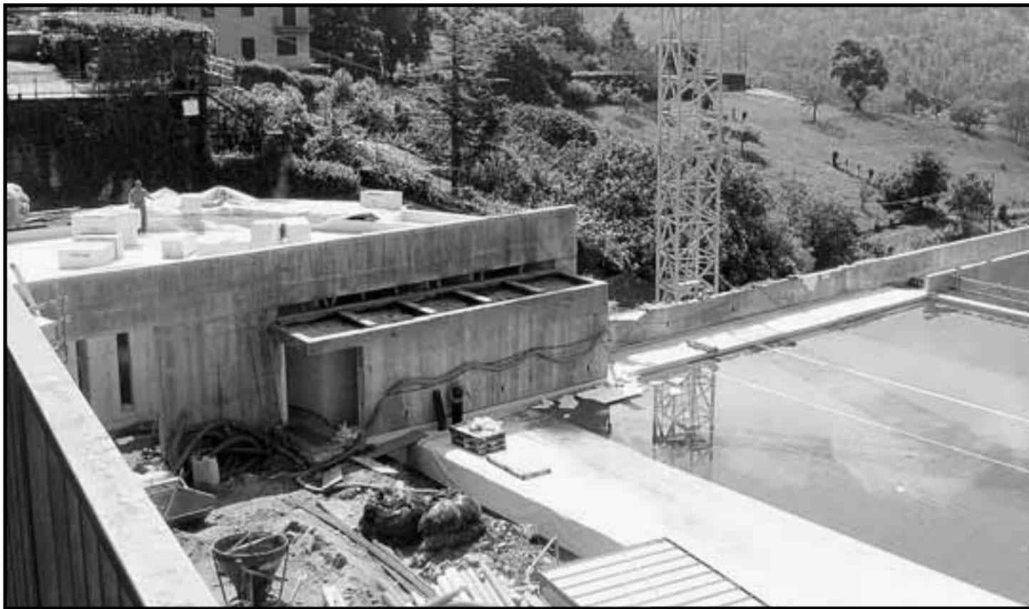
Il cantiere della nuova scuola materna alla Tribulina
