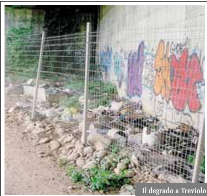
Il degrado a Treviolo
