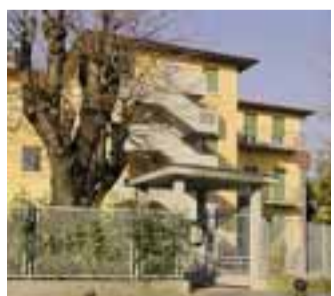
Villa della pace a Stezzano: i lavori di ristrutturazione durati 96 giorni
