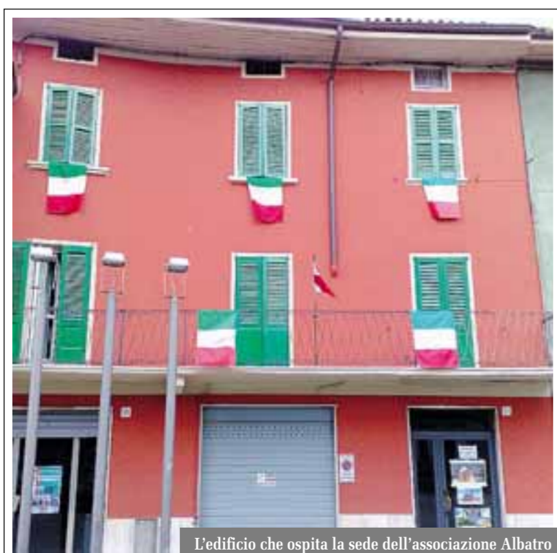
L'edificio che ospita la sede dell'associazione Albatro
