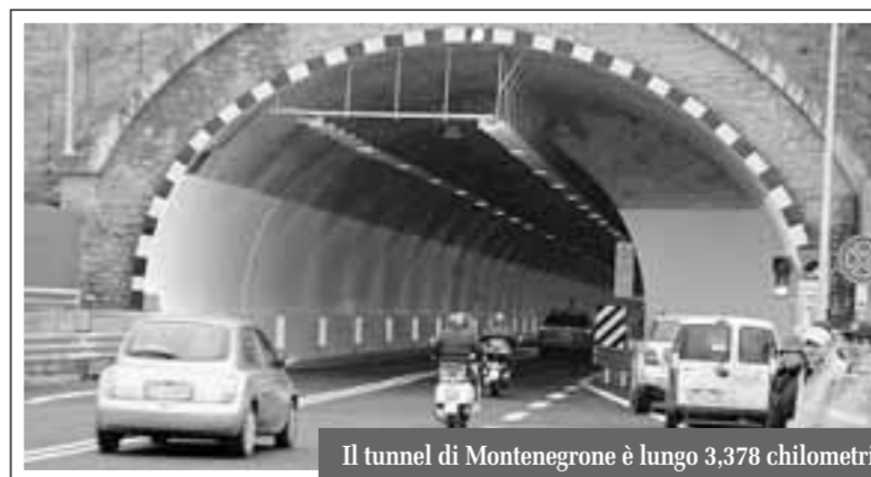
Il tunnel di Montenegrone è lungo 3,378 chilometri
