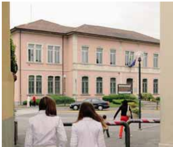
Acque agitate al Comune di Torre Boldone: sostituiti due assessori
