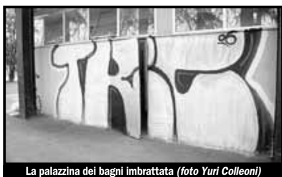
La palazzina dei bagni imbrattata (foto Yuri Colleoni)
