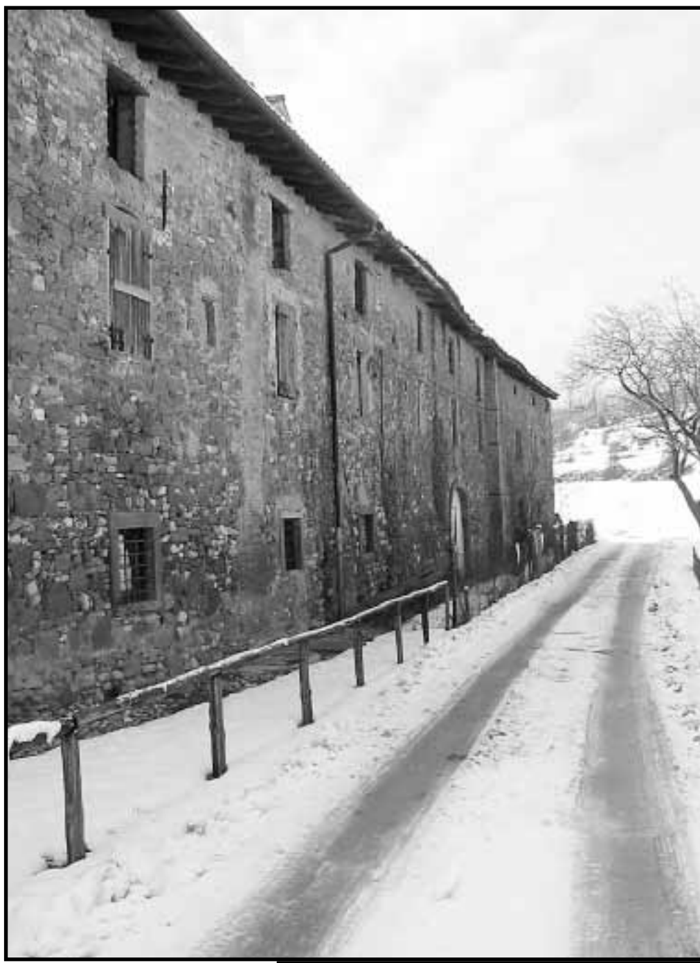
Al via il recupero della cascina del Parco dei Colli di Bergamo
