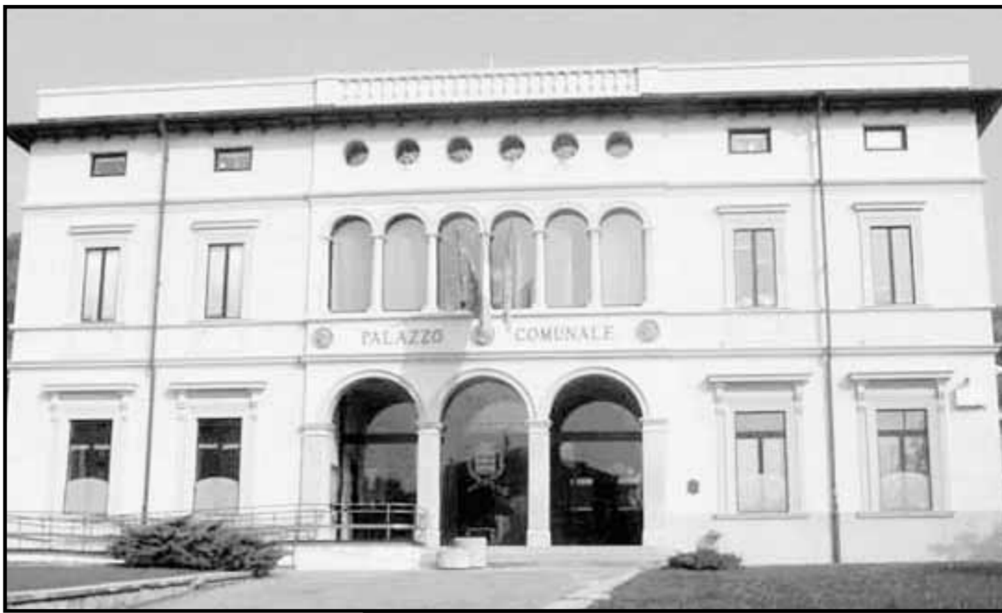
A nuovo le facciate del municipio di Scanzorosciate. Utilizzato un intonaco «mangia smog»
