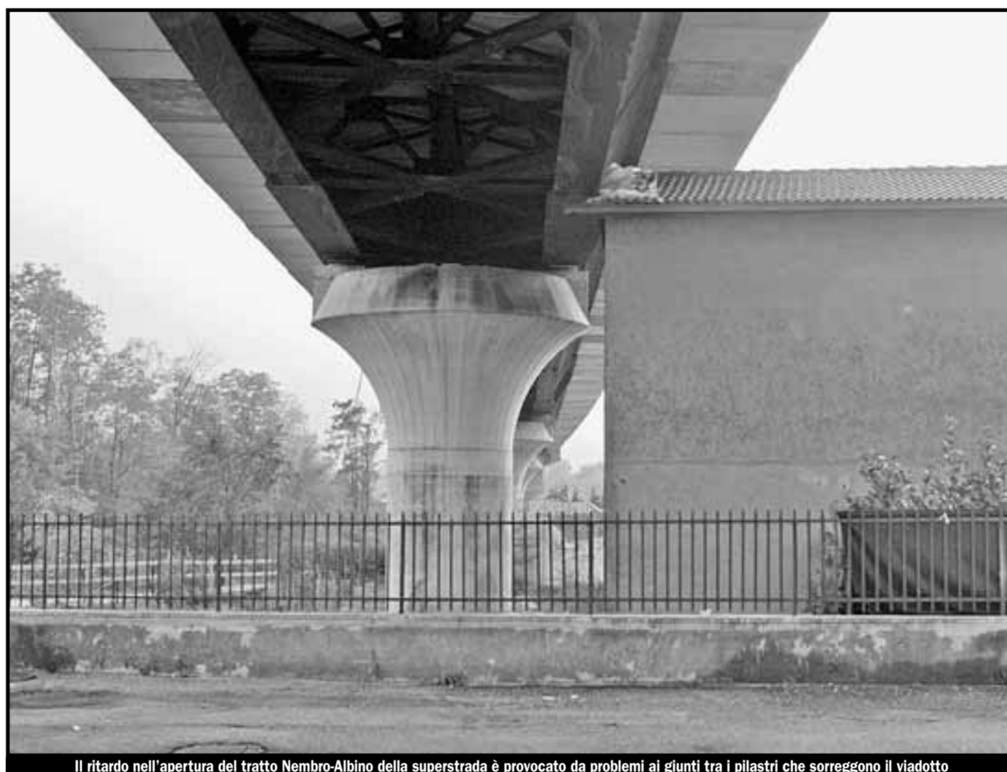
Il ritardo nell'apertura del tratto Nembro-Albino della superstrada è provocato da problemi ai giunti tra i pilastri che sorreggono il viadotto
