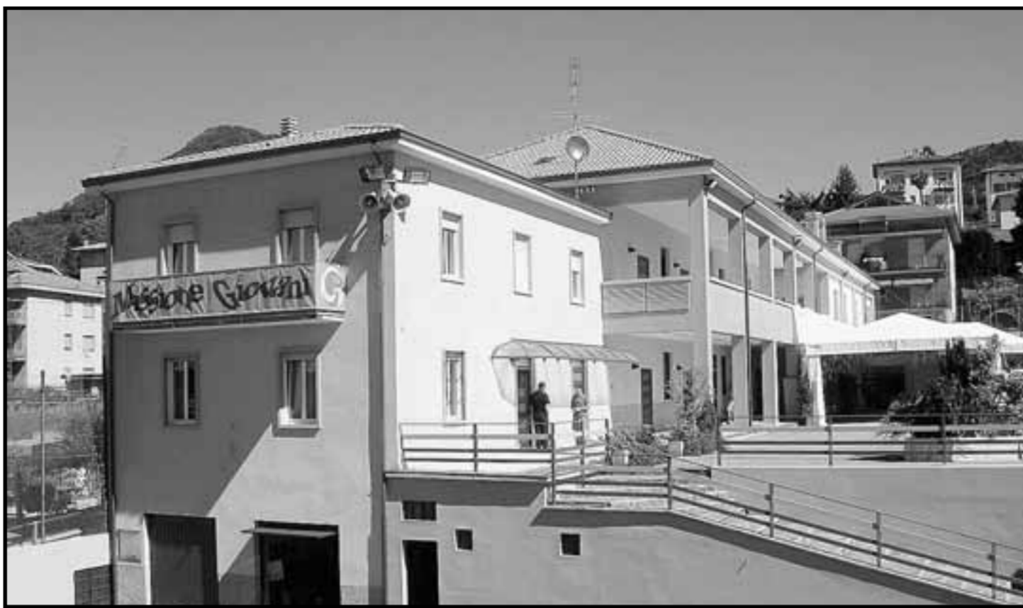
L'oratorio di Villa d'Almè rimesso a nuovo con due anni di lavori
