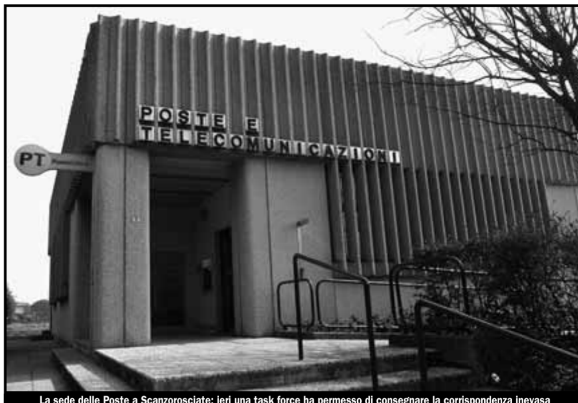
La sede delle Poste a Scanzorosciate: ieri una task force ha permesso di consegnare la corrispondenza inavasa
