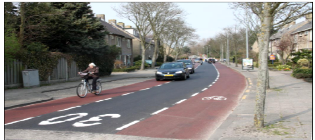
Esempio di strada urbana a prevalente uso ciclabile
