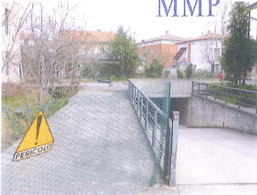
RAMPA AUTORIMESSE INTERRATE SULLA VIA H.TE S.MICHELE E AREA CORTILIZIA A EST-SUD/EST
