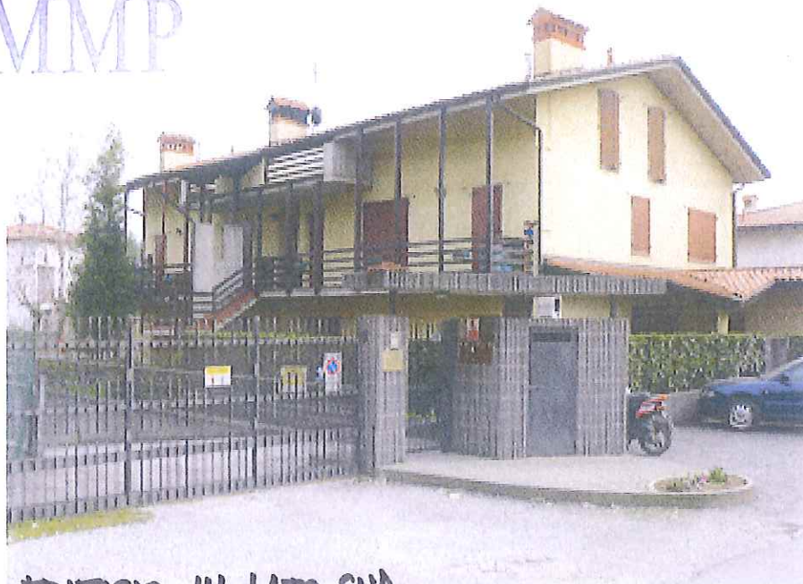
EDIFICIO IN LATO SUD
