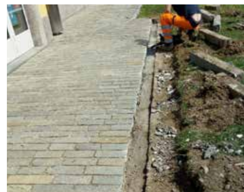
Sistemazione ingresso Poliambulatorio
