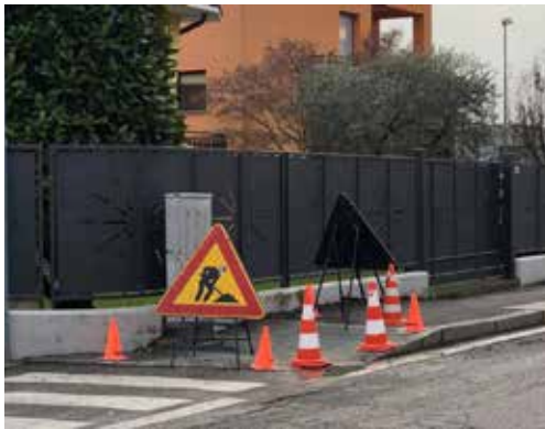
Sistemazione marciapiedi di Via Roma
