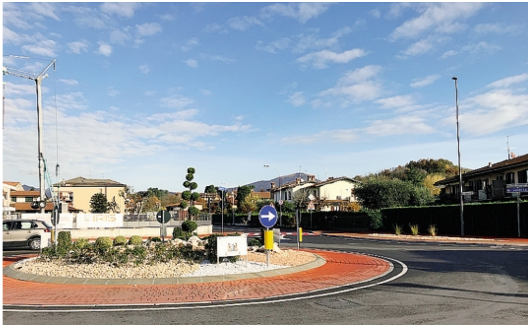
La rotonda da cui parte la strada lungo la quale verrà realizzata una pista ciclopedonale lunga 250 metri
