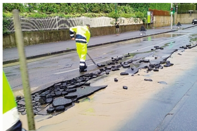
I danni della bomba d'acqua nell'agosto del 2016 in via Polcarezzo
