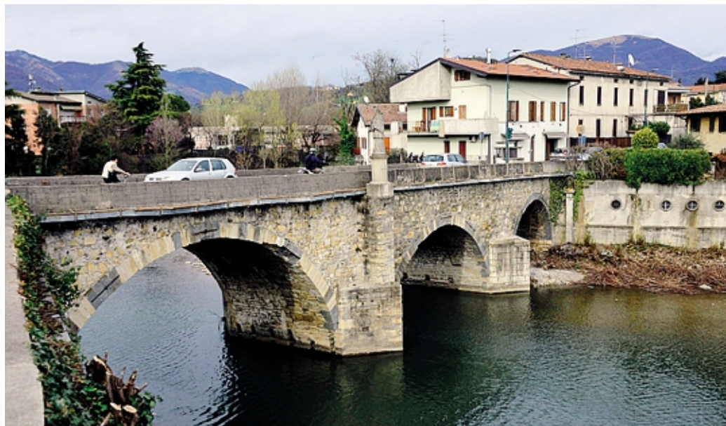
Foto d'archivio del Ponte Marzio che collega Gorle con Scanzorosciate e Pedrengo. Il cantiere dal 15 giugno
