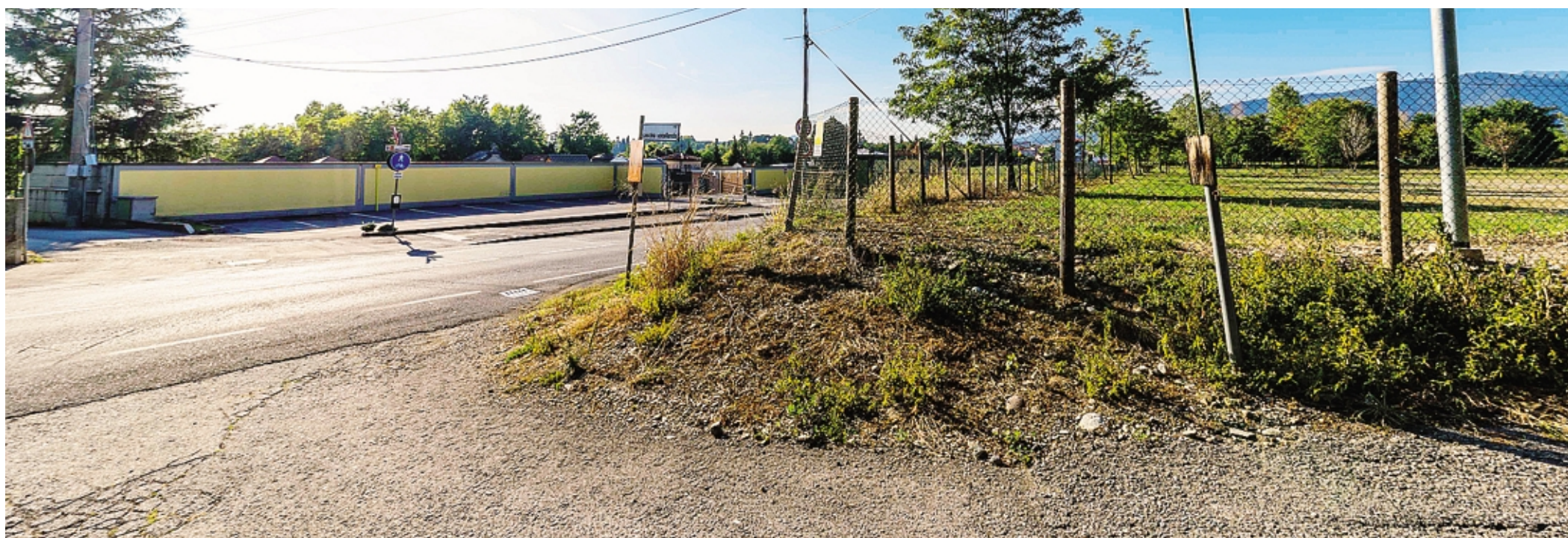
Il punto di via Piave, a Pedrengo, dove si immetterà la nuova strada e sarà realizzata una rotatoria FOTO PERSICO
