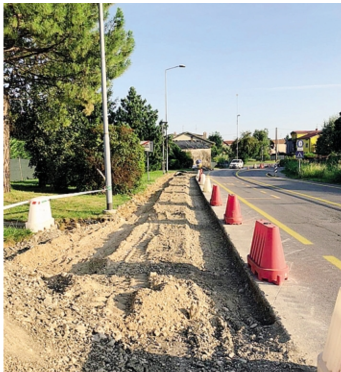
Il cantiere della nuova pista ciclopedonale
