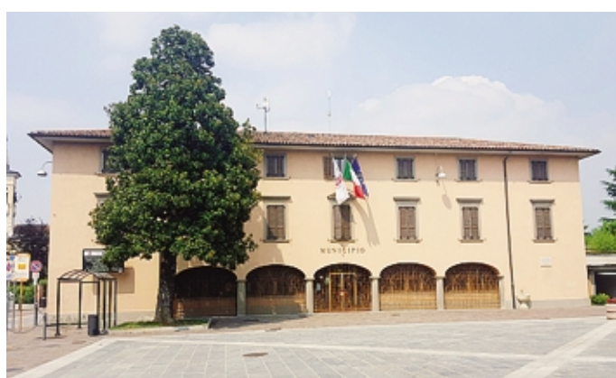
Il municipio di Valbrembo: verranno sostituiti i serramenti
