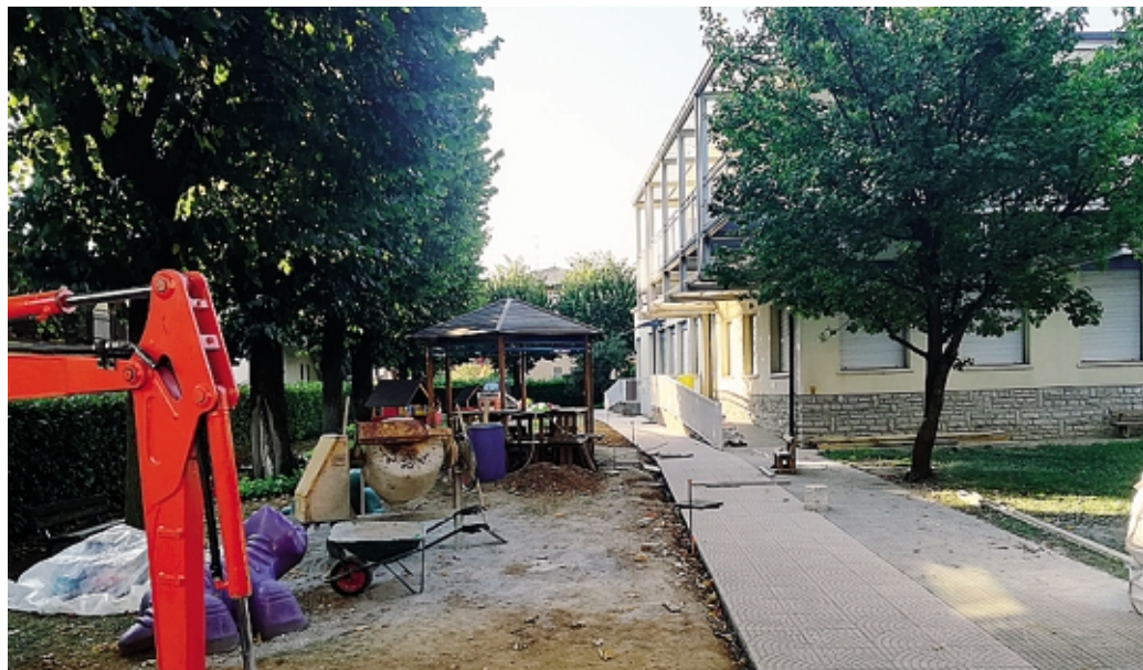
I lavori in corso alla scuola dell'infanzia di Orio al Serio
