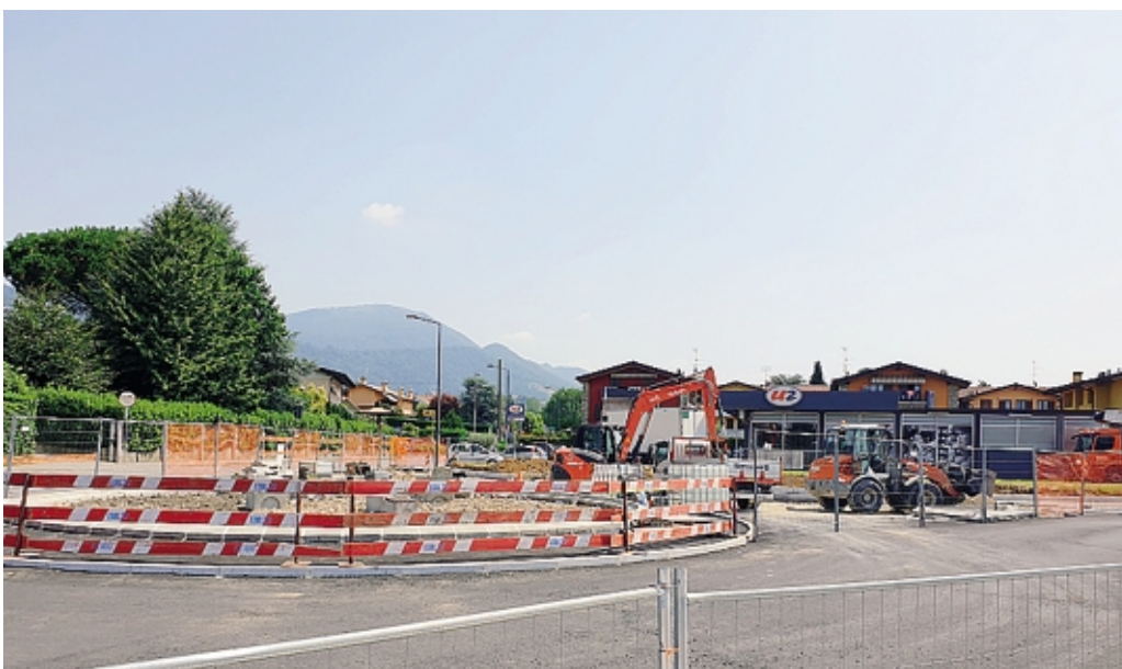
La nuova rotatoria in via di costruzione per rendere più fluido il traffico nella zona di Negrone
