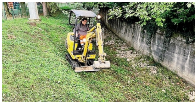
Pulizia dell'alveo anche sul torrente Gavarnia a Tribulina
