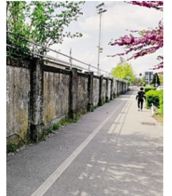
L'attuale muro di confine
