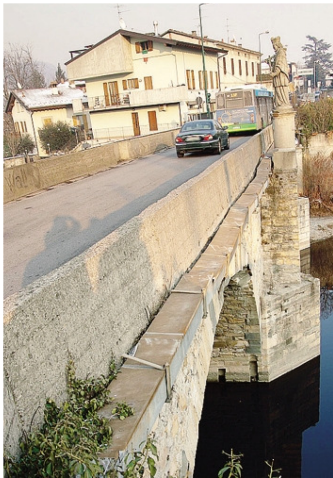
Il ponte Marzio a Gorle. Per pedoni e ciclisti arriva ora una passerella
