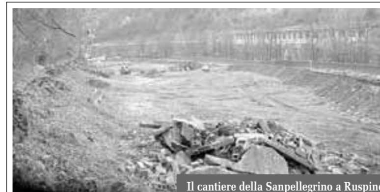
Il cantiere della Sanpellegrino a Ruspino
