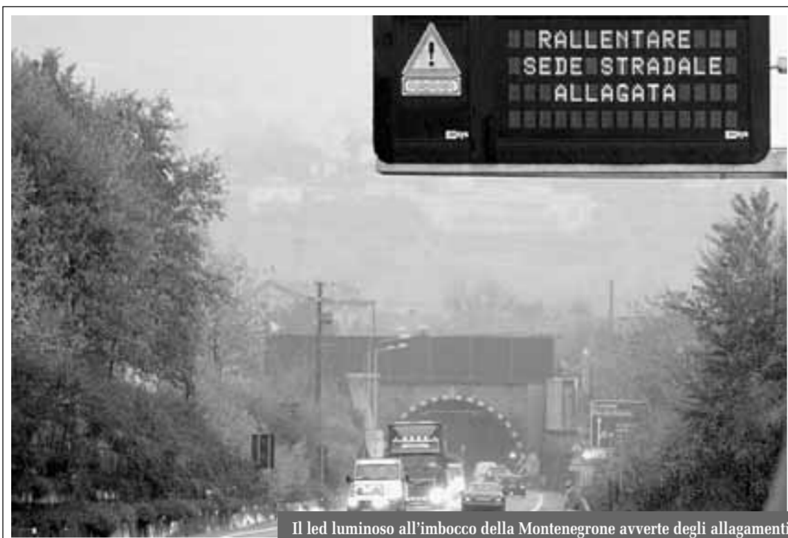
Il led luminoso all'imbocco della Montenegrone avverte degli allagamenti
